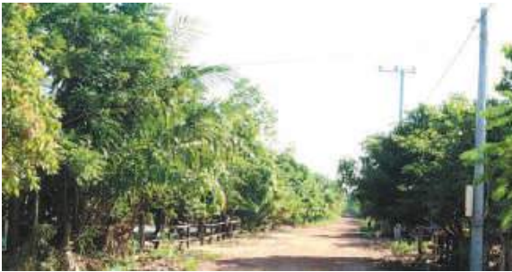
Hệ thống điện sinh hoạt khu dân cư số 04 do Công ty CPCS Bà Rịa - Kampong Thom xây dựng tại xã Kroyea, huyện Santuk, tỉnh Kampong Thom
