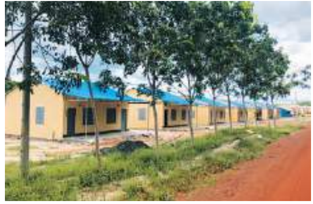
Nhà ở công nhân và đường điện do Công ty CP Cao su Bà Rịa - Kampong Thom xây dựng
