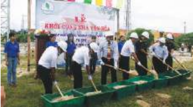
VRG tài trợ xây dựng Nhà văn hóa trên đảo Sinh Tồn. Trong ảnh: Khởi công xây dựng Nhà văn hóa vào năm 2011.
